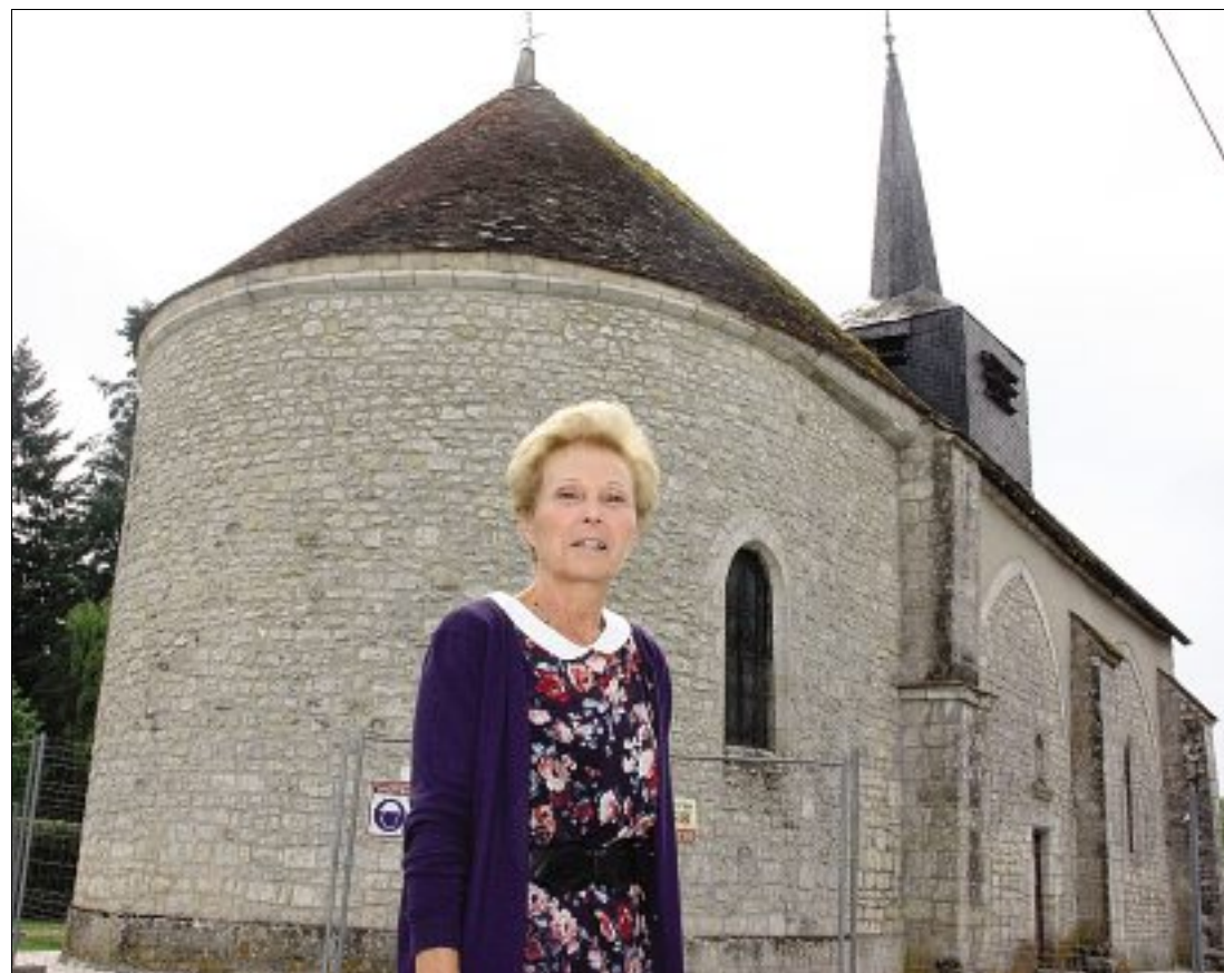
RÉNOVATION. Les travaux de rénovation de l'église du Moulinet-sur-Solin sont lancés, pour la plus grande satisfaction de Marie-Christine Meunier, maire de la commune.
