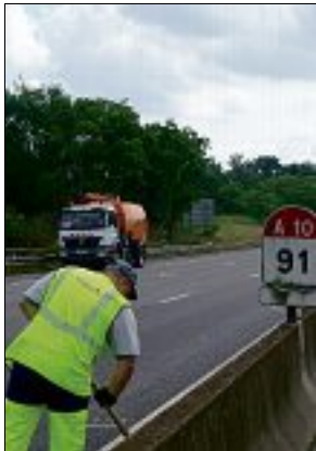
NETTOYAGE. Les débris sont en cours d'évacuation.
