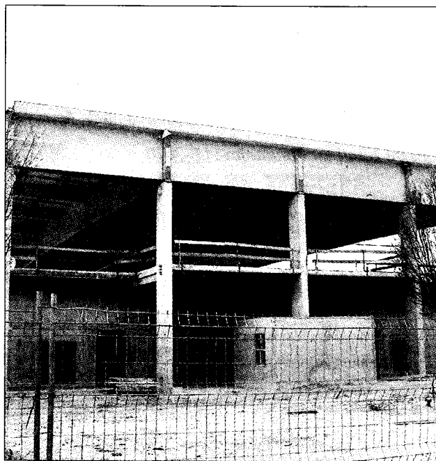
MARDI, A LA SOURCE. Les impôts locaux permettent entre autres de financer la construction du nouveau complexe sportif Minouflet.
