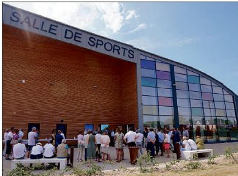
À Fay-aux-Loges, ce grand et beau bâtiment a fait l'objet de critiques, pour les installations.
