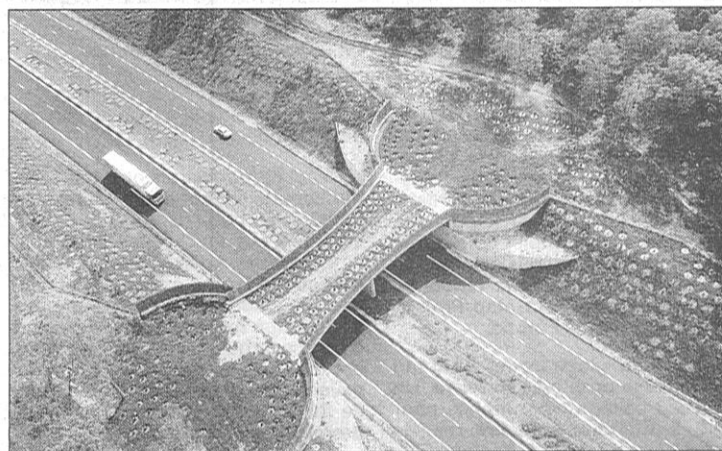
Une vue d'un passage à faune à hauteur du point kilométrique 51 sur la commune des Choux.
