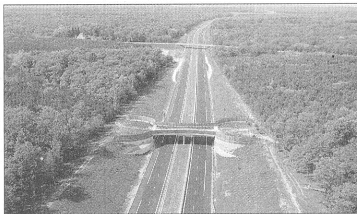
Un passage à gibier à hauteur du point kilométrique 47 sur la commune de Nogent-sur-Vernisson.
