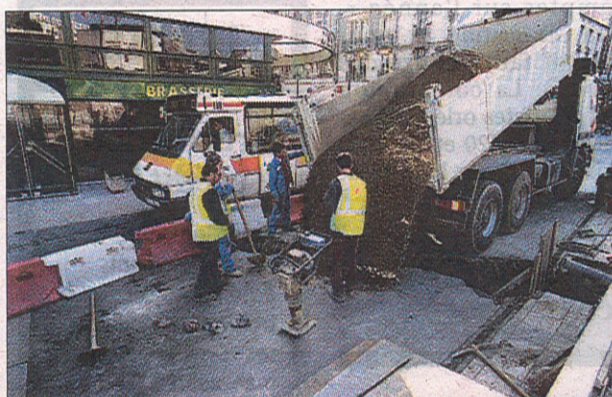
TRAVAUX. Le chantier de la ligne, débuté en 1998, a bouleversé la ville, comme ici, en haut de la rue de la République.
