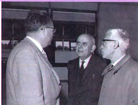
Roger Secrétain (à droite) en visite de chantier à La Source . Photo F. Pellicer.
