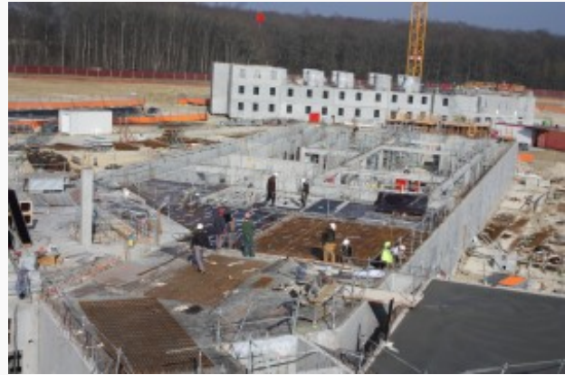
Le chantier de la nouvelle prison de Saran (Loiret) construit grâce à un PPP, maintenant terminée, en mars 2012.
