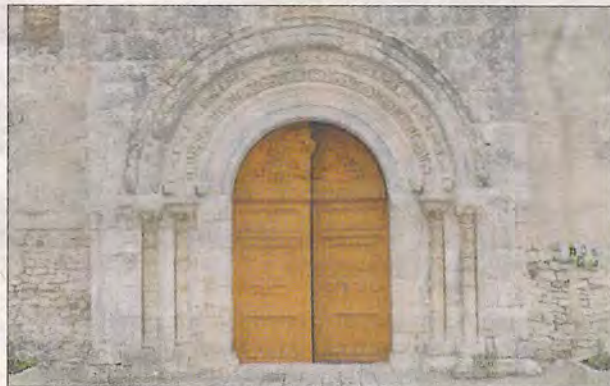
C'est la remise en peinture des vantaux du portail qui a été effectuée, en ocre jaune identique à la couleur originelle retrouvée.
