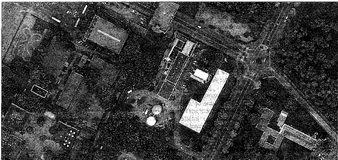
Un nouveau site d'implantation de la chaufferie sera installé à La Source pour novembre 2012. (Montage : ville d'Orléans)
