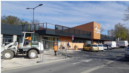
Plus de deux ans après le début des travaux, le chantier des halles Bolière à Orléans-La Source n'est toujours pas terminé © Radio France - Christophe Dupuy
