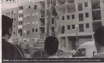
ESPOR. Les premières démolitions ont été faites, mais qu'il est aussi l'opportunité d'un changement des conditions de vie, au sein des lieux habités.
