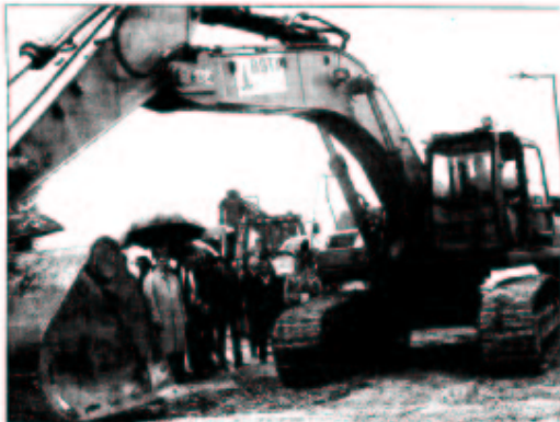
Lancement de la ZAC des Loges par les élus de la CCL, un premier coup de pelle pour la première tranche
