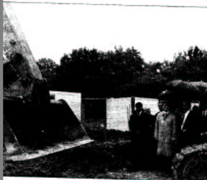
ici, sur le site de la ZAC des Loges. Le premier coup de pelle a été effectué par un entrepreneur spécialisé le lancement des travaux.
