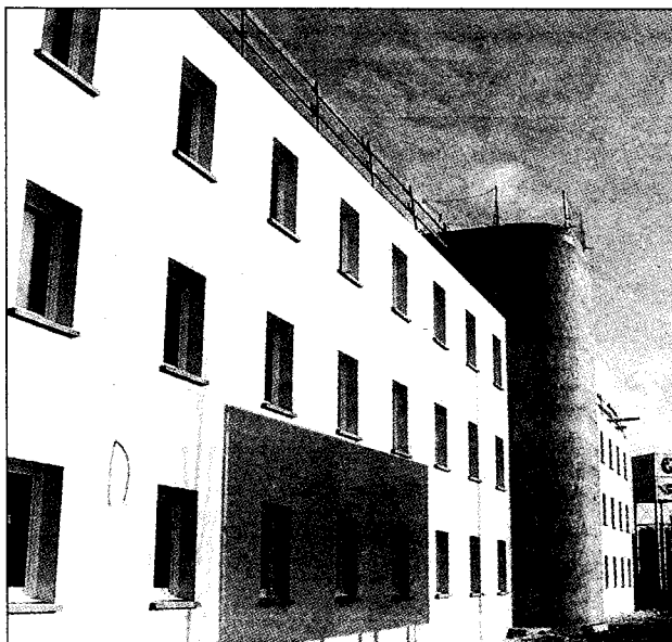
Le bloc de béton, avec un arrondi central, est en train d'être enduit. Finalement, il n'y aura pas de murs rideaux (vitrés).
